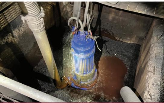
Pompe à boue submersible GPM-Eliminator
