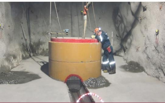
Pompe submersible GPM-Eliminator et puisard de Wilson
