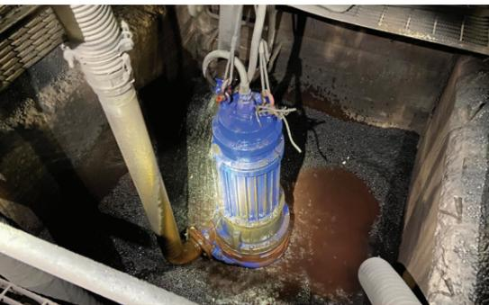
Bomba sumergible de lodo de GPM-Eliminator
